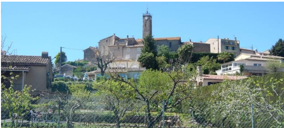
Fig. 3 // Vue depuis le chemin de la dame
