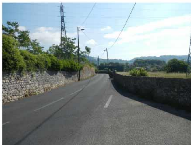
3 - Vue depuis la RD4 vers l'Est
