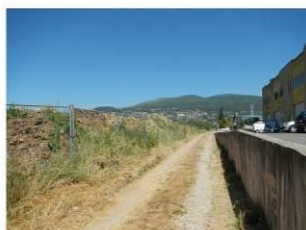
7 - Secteur de dépôts de remblais
