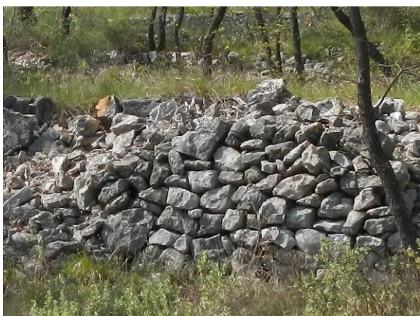
Ancien muret en pierre sèche
