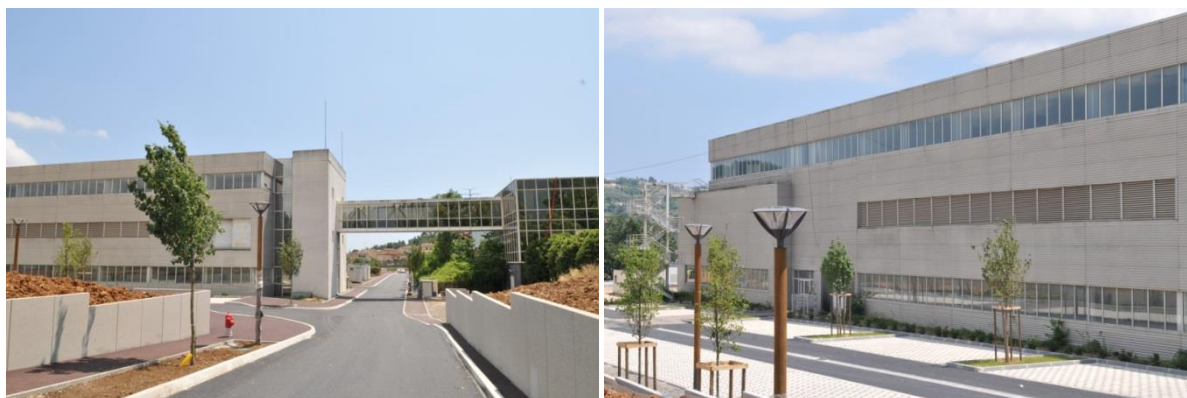
Fig. 16 // Le parc d'activités ArômeGrasse (Source : Communauté d'Agglomération du Pays de Grasse)
