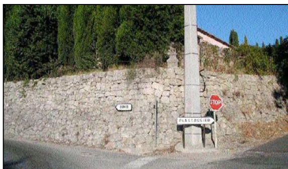
Mur voûte à l’angle du Chemin de la Rourée et du Chemin de Saint- Mathieu.
