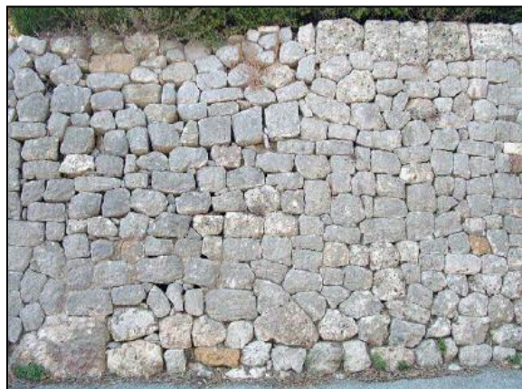
Mur de soutènement du cimetière Sainte-Brigitte
