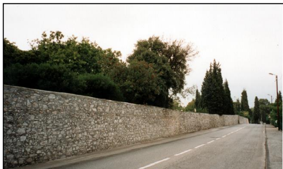
Grand mur des "Bois Murés"
