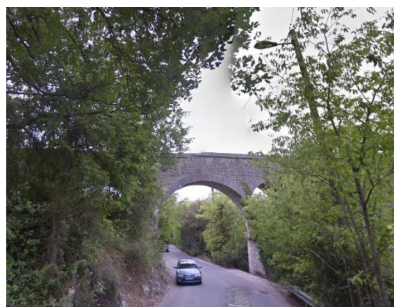
PONT CANAL Sur le chemin du Moulin de Brun
