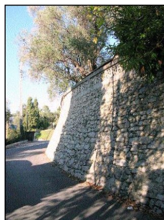
Mur voûte Chemin du Plan
