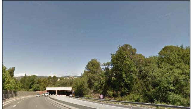
Le boisement des Aspres de part et d’autre du sommet de la pénétrante et couvrant le dernier tunnel
