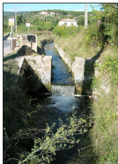
Déversoir Chemin de Roure La Gache
