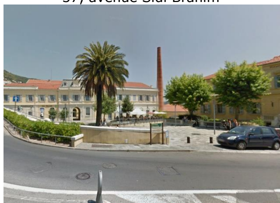
Cheminée ZAC de Roure 57, avenue Pierre Sépard
