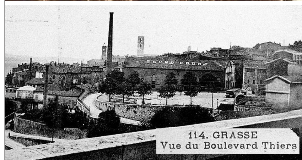
Photos anciennes du site Martelly au XIX ème siècle
