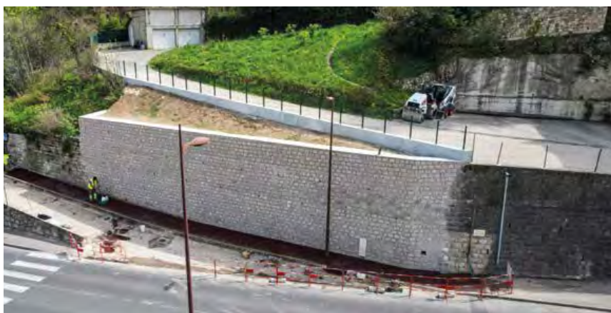
RÉCEPTION DES TRAVAUX DU MUR DE SOUTÈNEMENT AVENUE PIERRE SÉMARD
