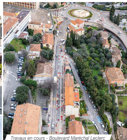
Travaux en cours - Boulevard Maréchal Leclerc
