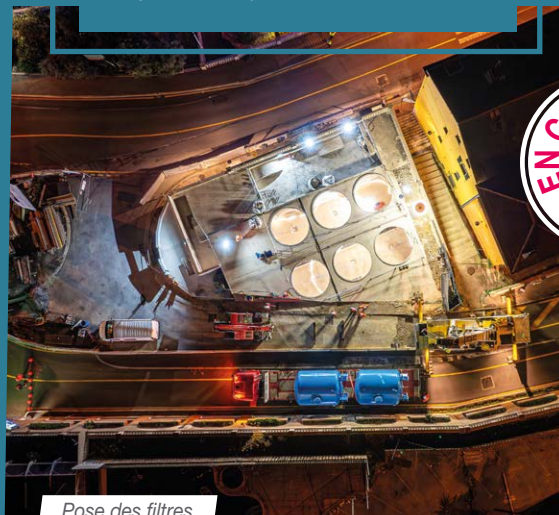
Pose des filtres
