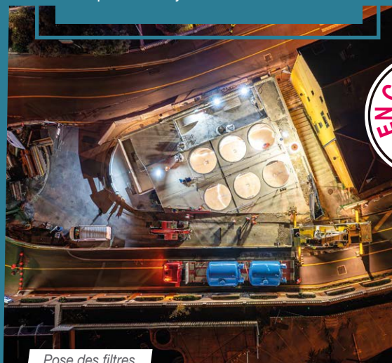
Pose des filtres
