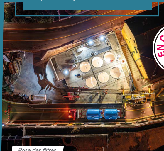
Pose des filtres
