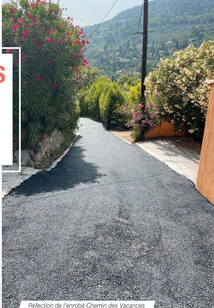
Réfection de l'enrobé Chemin des Vacances
