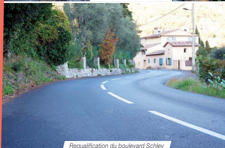
Requalification du boulevard Schley
