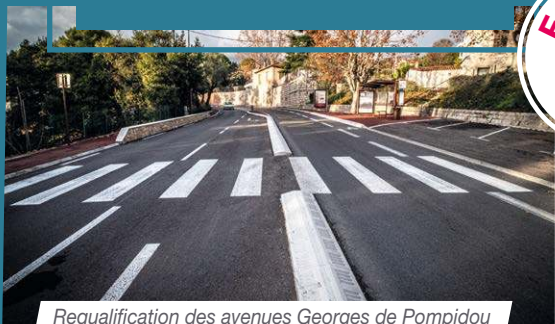
Requalification des avenues Georges de Pompidou et de Lattre de Tassigny
