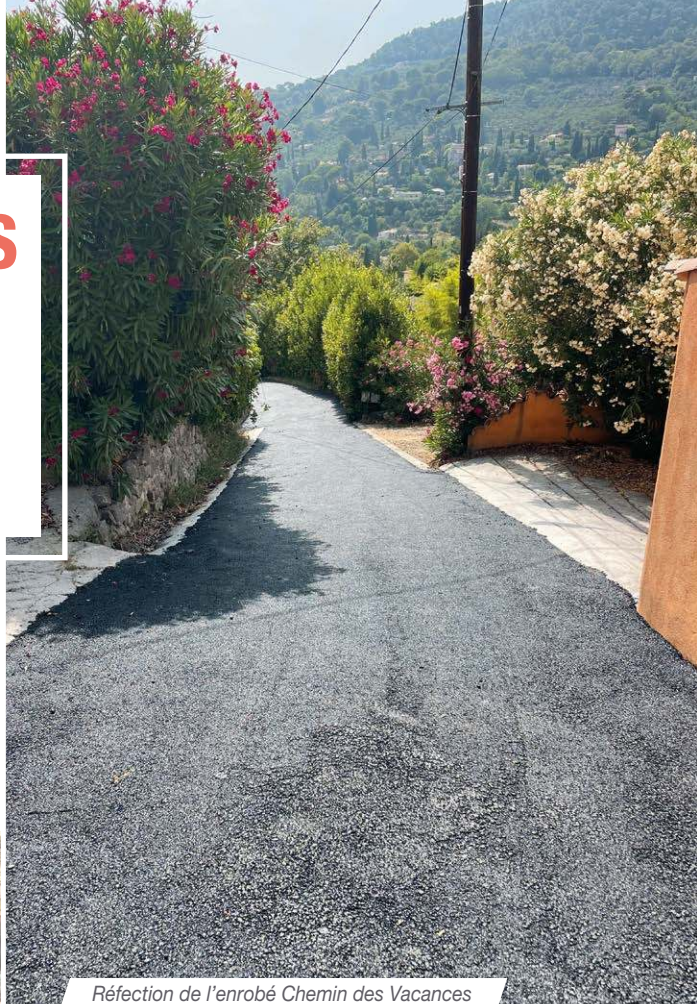
Réfection de l'enrobé Chemin des Vacances
