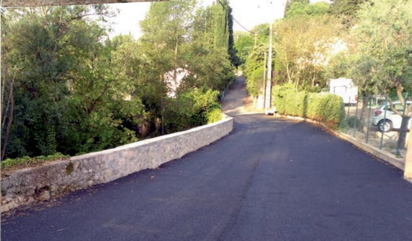
1. **Requalification** de la rue Gazan : travaux de requalification comprenant le renouvellement des réseaux eau / assainissement, création de réseaux fibre, télécom, télésurveillance et dallage avec dalles en pierres de luzerne. **TRAVAUX TERMINÉS**
